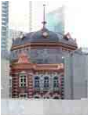
起工後復原工事中の時計台(平成19年)
