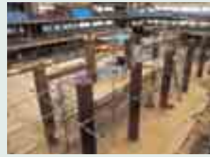
2005.1 組立の開始。柱を立て始める
