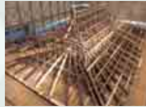
2006.11 屋根の骨組となる小屋組の組立て
