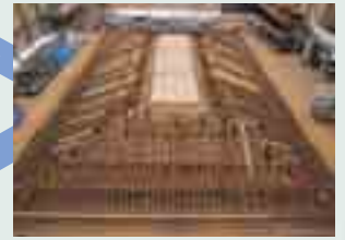
2006.6 地垂木の取付が完了する
