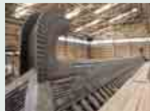
2007.8 大棟両端に鷗尾が昇る
